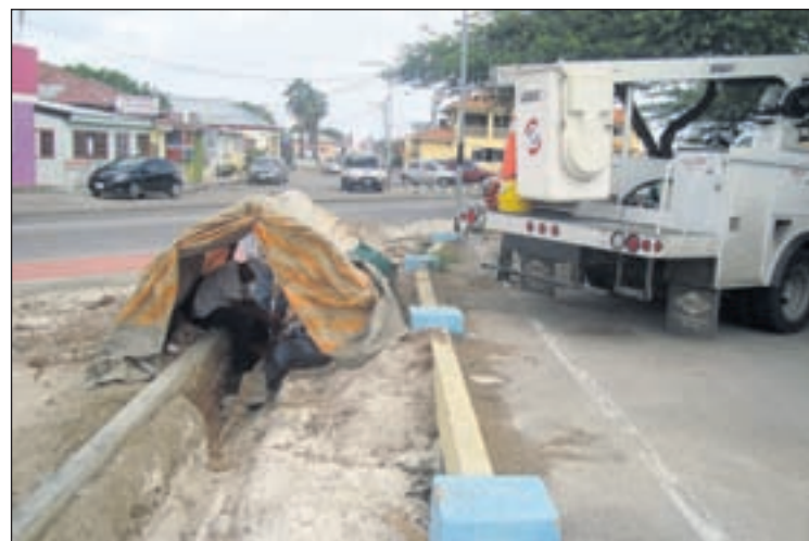
Riba e combinacion di potret aki nos por mira e trahadonan di Setar bezig trahando pa soluciona e problema cu a presenta cu un waya principal di telefon na haltura di hospital bieu, y cu a afecta e sector comercial di centro di ciudad.
